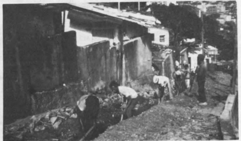
Lavori di urbanizzazione in una favela
