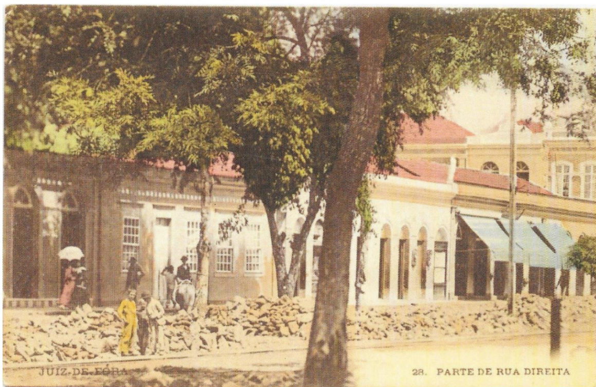
Figura 39 – Obras de calçamento am andamento na rua Direita
