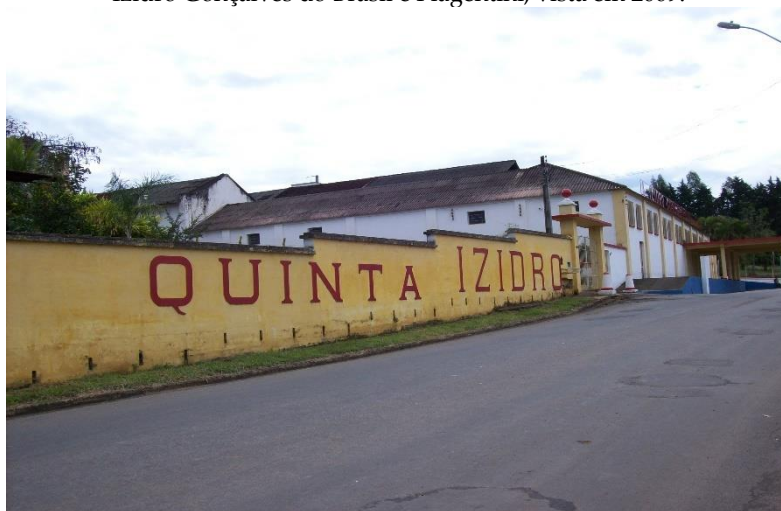
Figura 4. Estrutura da adega que pertenceu a Antenor Risso, Amadeu Masa, Izidro Gonçalves do Brasil e Piagentini, vista em 2009.
