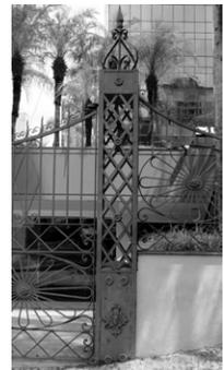
mais simples e teve suas partes montadas com parafusos e rebites, formando uma estrutura estável.
