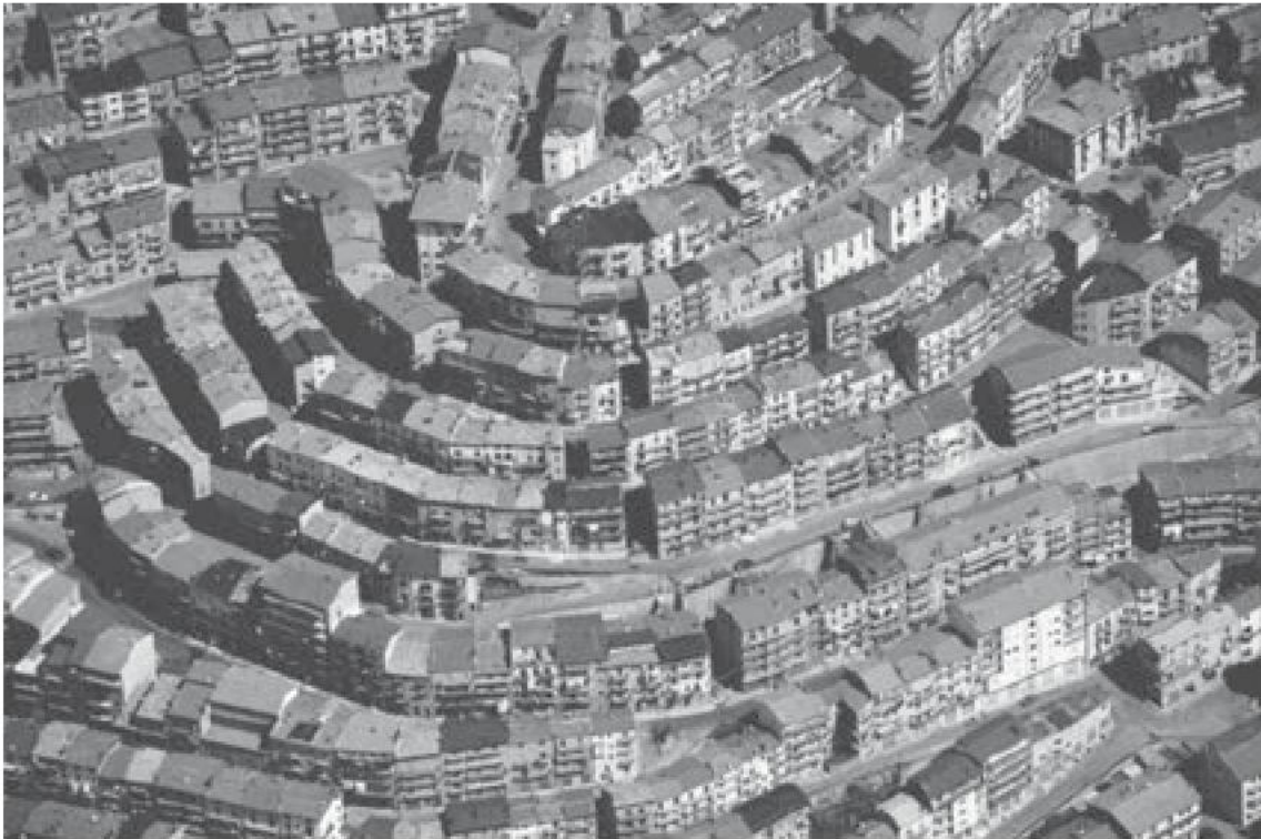
Cidade de San Giovanni in Fiori, Província de Cosenza, região da Calabria
