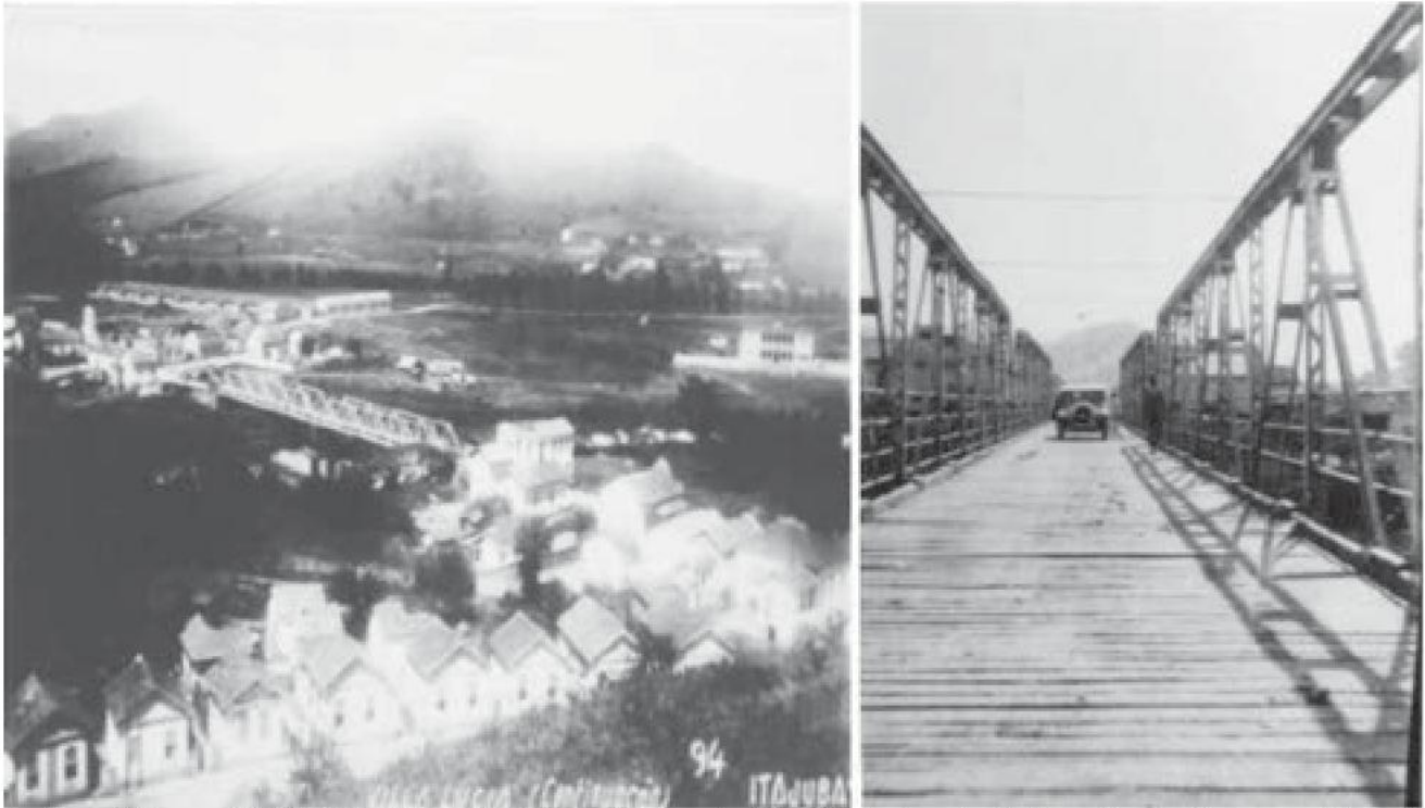
Ponte metálica em Itajubá, à Rua Dona Maria Carneiro, construída pelos imigrantes italianos Jacob e Francesco Masselli
